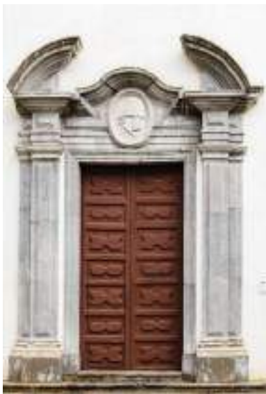
Portale principale d'ingresso alla chiesa con l'emblema benedettino e la data 1748
